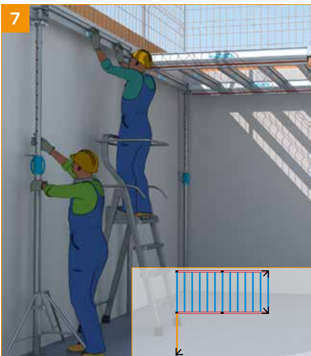
- Mise en place d'une nouvelle poutrelle secondaire sur ST.
